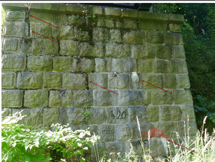
Obrázek 3. Opěra O 01 líc dříku a úložný práh –
